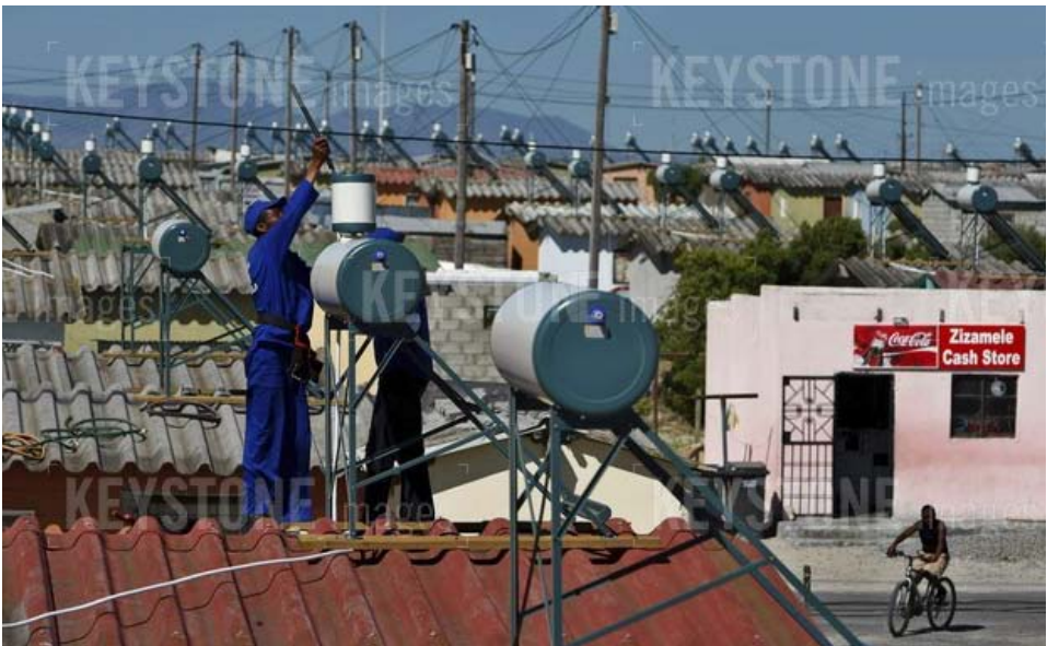
Beim Installieren einer solar angetriebenen Wasserheizung – Südafrikas erstem CDM-Projekt.
